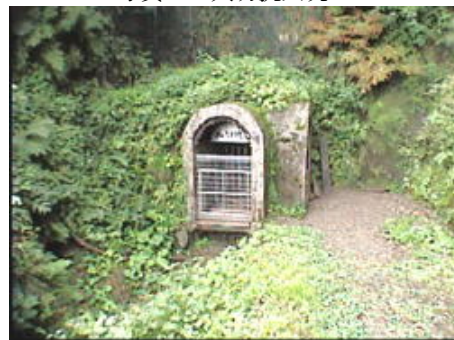
写真24：上下左右ともなめらか。横には水路も
