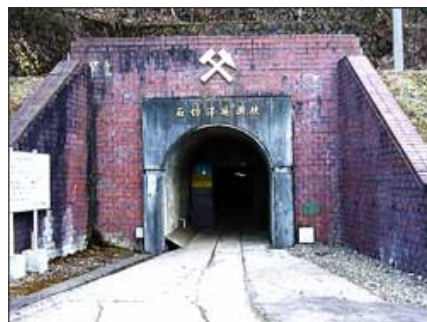
立派な坑道入口。通路にゲージの跡が見える
